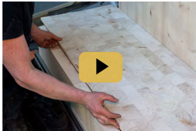
Instruktionsfilm läggning av kubbtrappa
