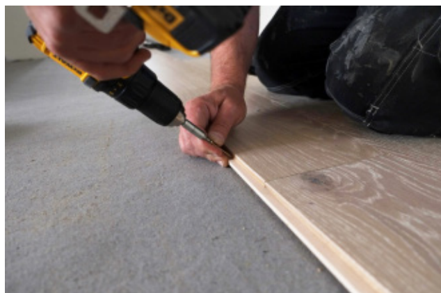
Lösfjädern skall skruvas eller spikas
