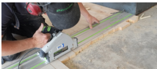
Använd en cirkelsåg med tillhörande skena.
