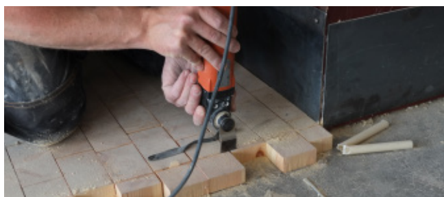
Mindre sågningar och passningar utförs lämpligen med Fein Multimaster.
