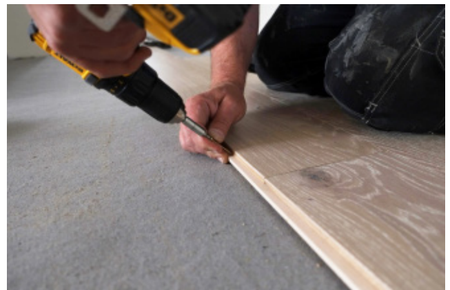
Lösfjädern skall skruvas eller spikas
