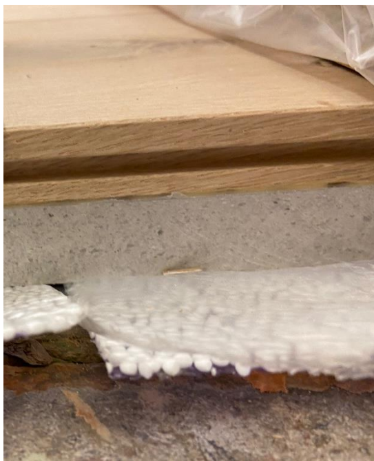
Bild 6 – montering från sida. I ordning uppifrån Golv, kartplast, cementskiva och Tuplex
