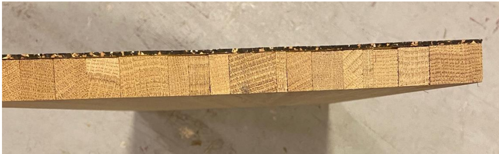
Bild 3 – Närbild av tvärsnitt. Golvskivorna är ej ihoplimmade, men limmade neråt.
