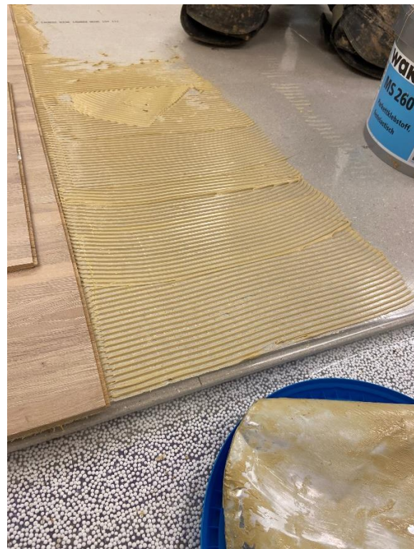
Bild 5 – Limning av träskivor på cementskiva.
