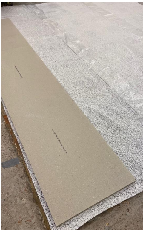
Bild 4 – Cementskiva på Tuplex.
