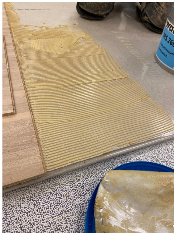
Bild 5 – Limning av träskivor på cementskiva.
