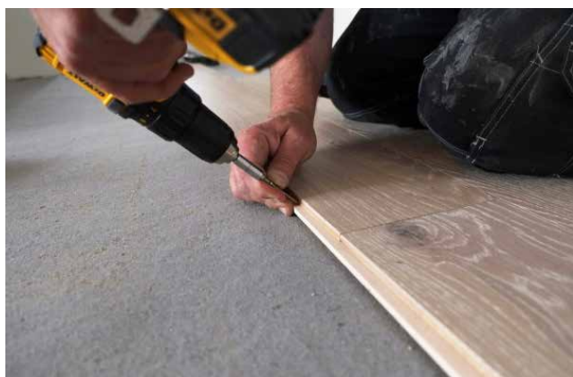
Lösfjädern skall skruvas eller spikas
