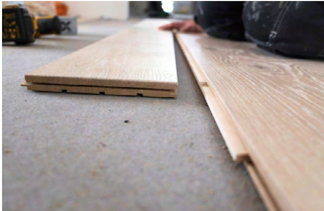
Vändning med lös fjäder
