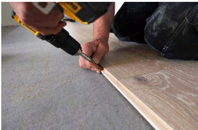
Lös fjädern skall skruvas eller spikas
