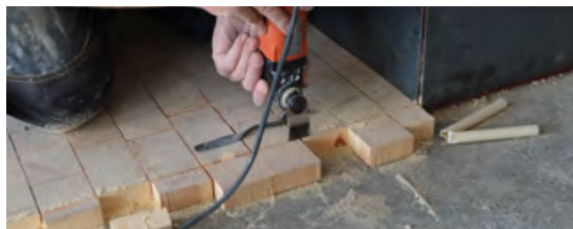
Mindre sågningar och passningar utförs lämpligen med Multimaster.
