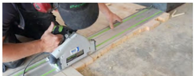
Använd en cirkelsåg med tillhörande skena.
