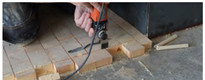
Mindre sågningar och passningar utförs lämpligen med Multimaster.
