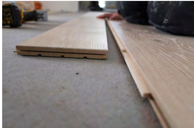
Vändning med lösfjäder
