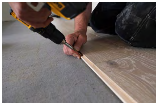
Lösfjädern skall skruvas eller spikas
